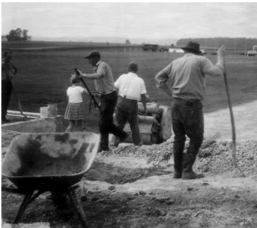
Letzte Arbeiten am neuen Sportplatz
